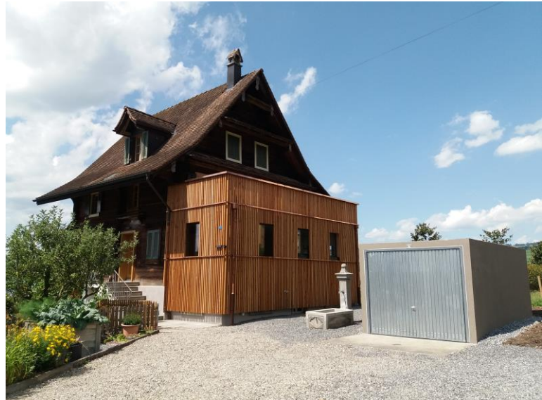
Pfarrhaus nach dem Umbau
